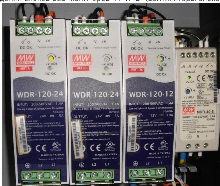
Рис.9 Блоки преобразователей напряжения номиналом 24V DC, 12V DC и 5V DC
