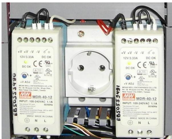
Рис.8 Блоки преобразователей напряжения номиналом 12V DC и розетка электропитания
