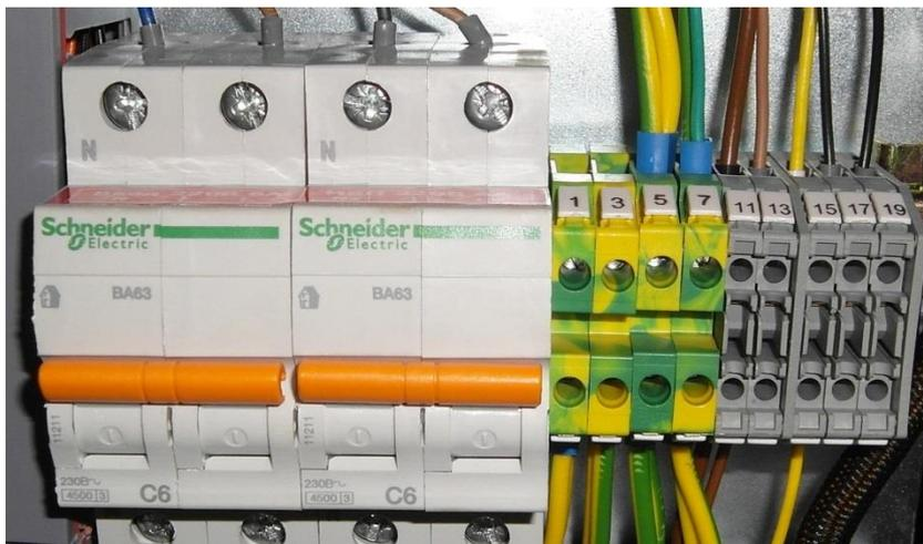
Рис.6 Автоматические выключатели и блок клеммных зажимов
