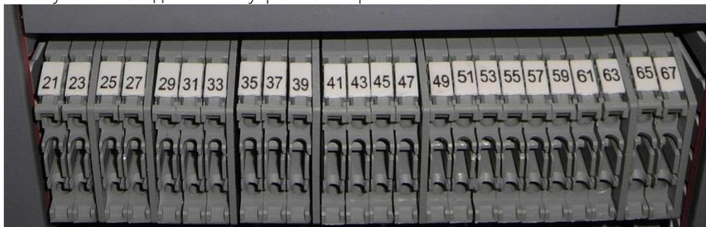
Рис.7 Блок клеммных зажимов.
